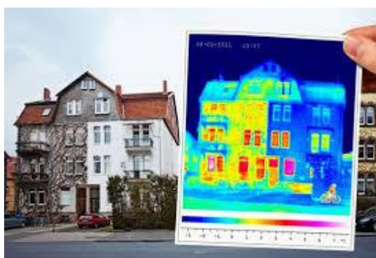
5. ábra Hőveszteségek infraképe homlokzaton (forrás: www.tm-bau.hu)
